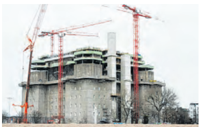
Der alte Bunker ist schon hoch, er bekommt jetzt aber noch mehr Stockwerke. Foto: dpa
