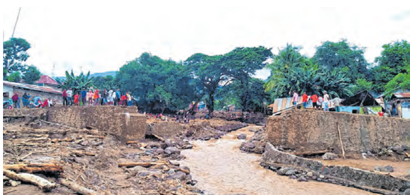
Im Land Indonesien in Asien zerstörten starke Überschwemmungen auch diese Brücke. Foto: dpa
