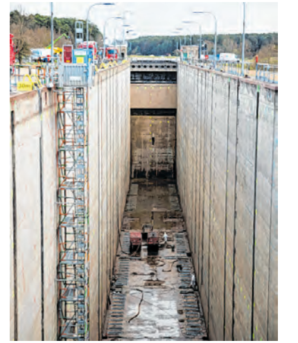
Für eine Kontrolle wurde die Schleuse leergepumpt. Foto: Daniel Karmann, dpa
