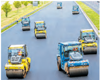
Ganz schon flink: Die Bauarbeiter können pro Minute rund fünf Meter Strecke Autobahn mit Flüsterasphalt belegen. Foto: Kneffel, dpa
