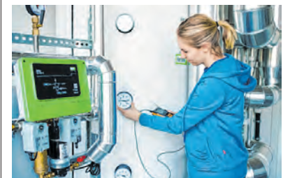
Antonella Menrath ist Auszubildende zur Anlagenmechanikerin Sanitär-Heizung-Klima. Foto: Uwe Anspach, dpa
